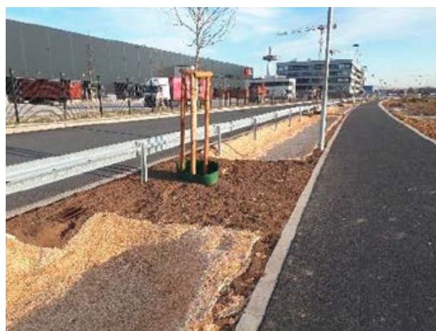
Im direkten Anschluss an den Afferder Bach musste ein offenes Grabenprofil erstellt werden.
