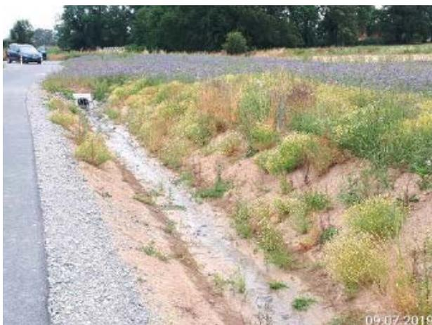
Zur Vorklämung und Rückhaltung des klärflichtigen Niederschlagswassers wurden Mulden-Rigolen-Systeme erstellt.
