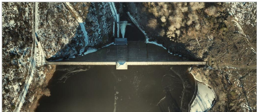
Mit Drohne erzeugtes Übersichtsfoto des Planungsbereiches (Staumauer Talsperre)
