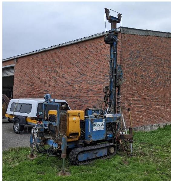
Für den Aushub des Leitungsgrabens musste das Grundwasser bauzeitlich abgesenkt werden. Um die Ausdehnung der Absenktrichter zu kontrollieren, wurden 148 Grundwassermessstellen (GWM) auf privaten Grundstücken entlang der Trasse errichtet. In den GWM wurden vollautomatische Datenlogger eingebaut, die in kurzen Messintervallen die Grundwasserstände auf ein Onlineportal übermittelten. Mit der
